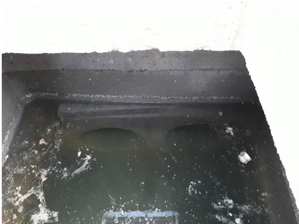
Figura 8: Alto= ovest: sifone con 2Ø80 (fondo tubo a -1,64m da ciglio asfalto)
