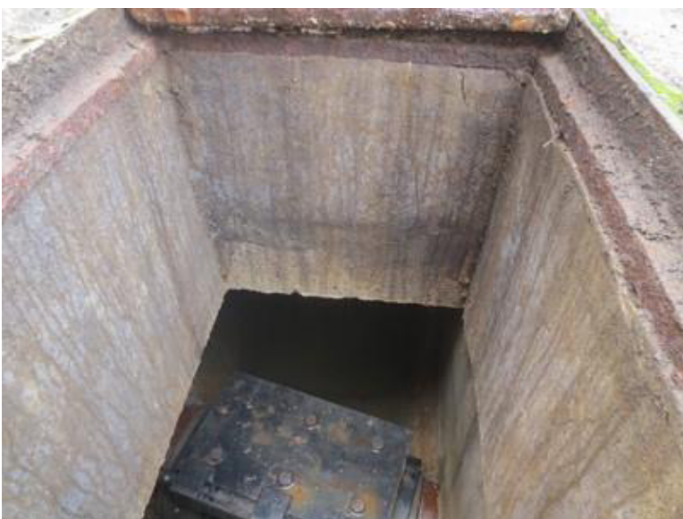
Figura 5: Alto= sud: by-pass tubo acque nere/miste.
